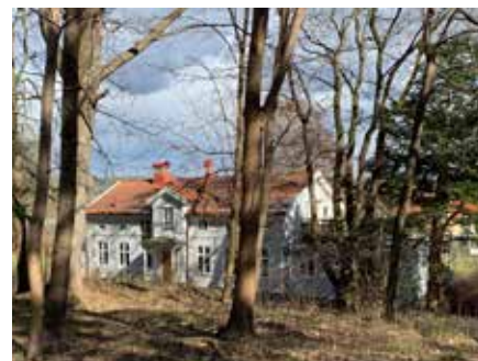
Bild: Tofta Nordgård byggdes 1882 och användes tidigare som Prästgård.
