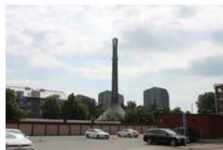
Bild: Före detta panncentralen, Tratten
